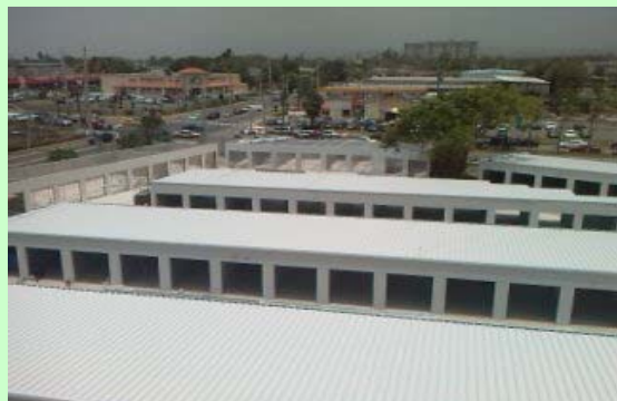
Techo sobre Mini Warehouse de Carolina
