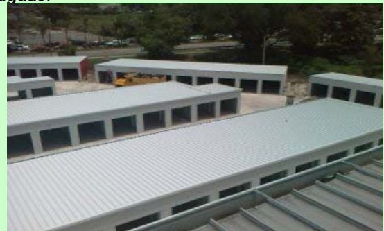
Techo sobre Mini Warehouse de Carolina
